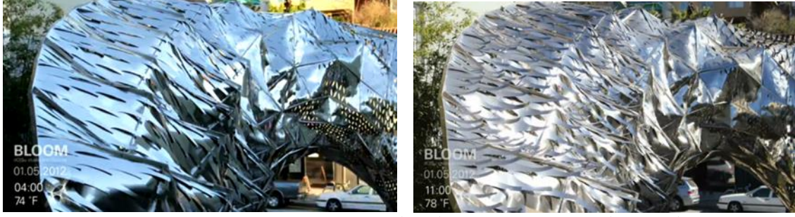
شكل (14) يوضح الحركة الميكانيكية التي تحدثها المواد الحرارية ثنائية المعدن مع اختلاف درجات الحرارة في معرض بلوم في لوس انجلوس
