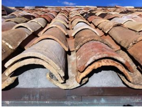
شكل (6) بلاطات طفلية متراكبة وصورة توضيحية لشكل السقف
